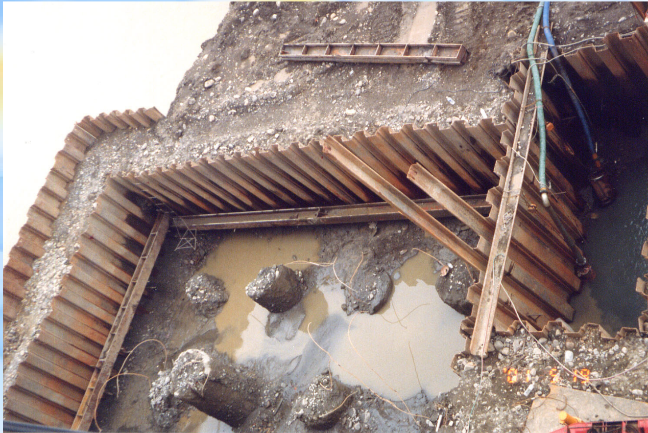
鋼版樁圍堰止水
