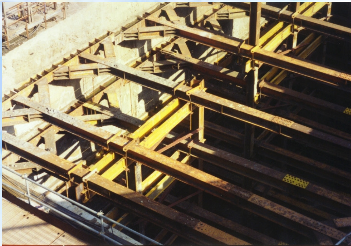
圖5-5-5A 水平支撐工法(鐵路地下化)
